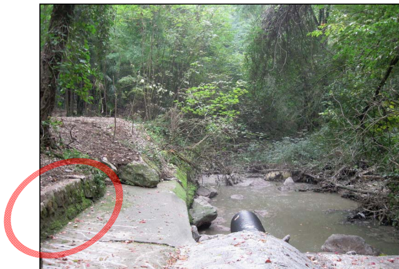
FOTO 17 - particolare di un vecchio muro in pietra di protezione spondale subito a valle del terrapieno di Viale Oriani. Foto ripresa da monte verso valle, sponda sinistra.
