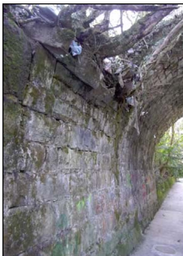
FOTO 14 - particolare del muro di sostegno in pietra lungo le spalle del vecchio ponte.
