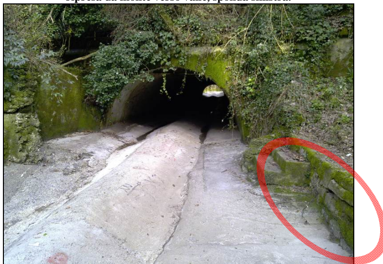
FOTO 18 - vecchio muro in pietra di protezione spondale subito a valle del terrapieno di Viale Oriani. Foto ripresa da valle verso monte, sponda sinistra.
