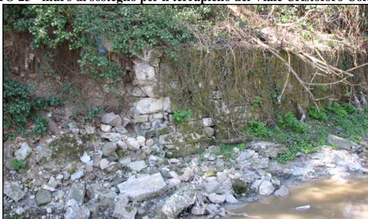
FOTO 24 - muro di sostegno in pietra squadrata avente una altezza di 2,5m presso il terrapieno di viale Colombo
