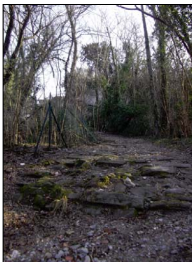
FOTO 15 - Via del Boschetto sopra il vecchio ponte. Si nota l'emergenza della vecchia struttura del ponte ad arco. Il progetto prevede la risistemazione del sedime preservandone le caratteristiche.
