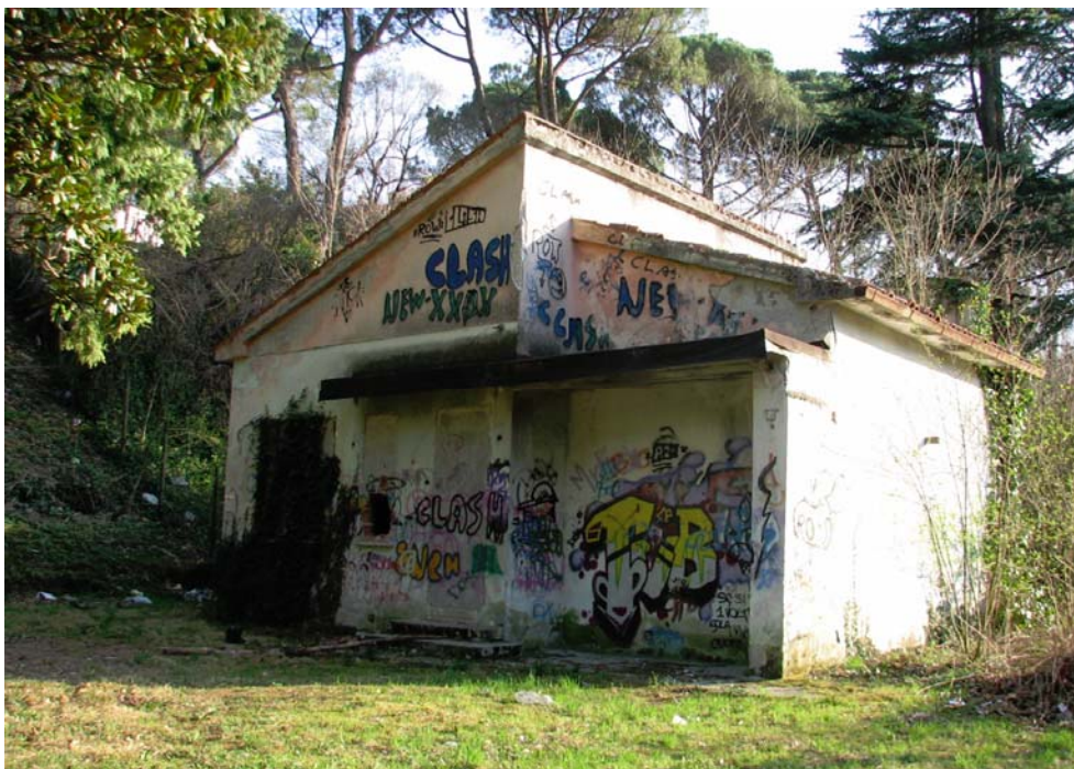
Figura 85: stato di fatto dell'edificio da ristrutturare come punto informativo di ingresso e accoglienza al parco.
