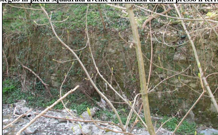
FOTO 25 - muro di sostegno in pietra squadrata avente una altezza di 2,5m presso il terrapieno di viale Colombo
