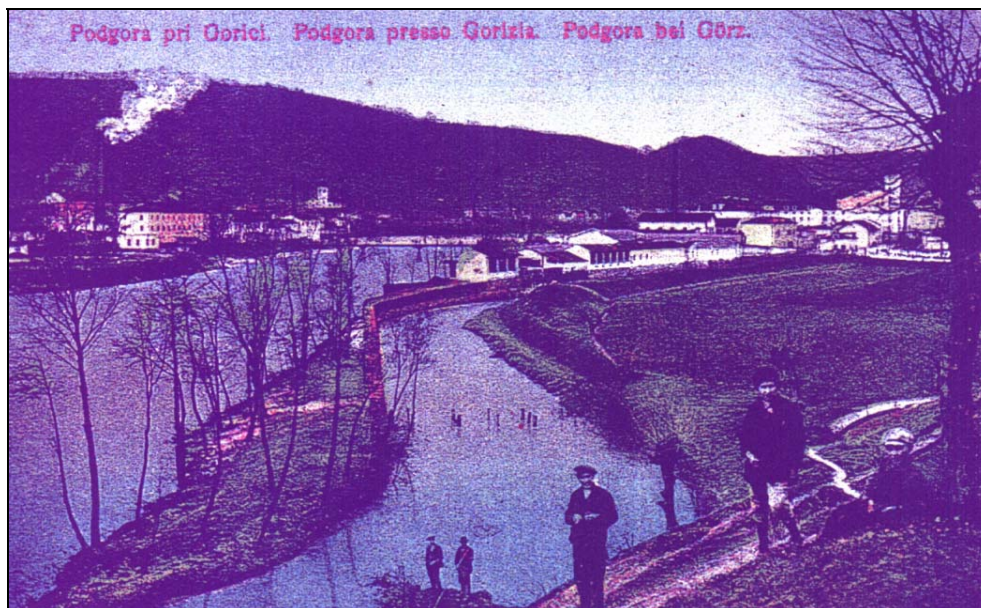
Figura 30: cartolina fine '800 inizio '900 (collezione del geom. Roberto Ballaben): sbocco del Corno nell'Isonzo (il canale a servizio degli stabilimenti industriali).
