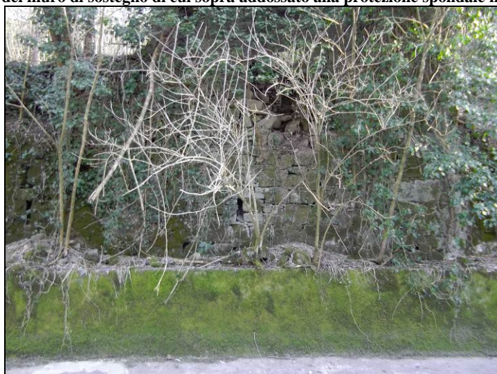
FOTO 6 - vista frontale del muro di sostegno con al di sotto la protezione spondale in calcestruzzo.
