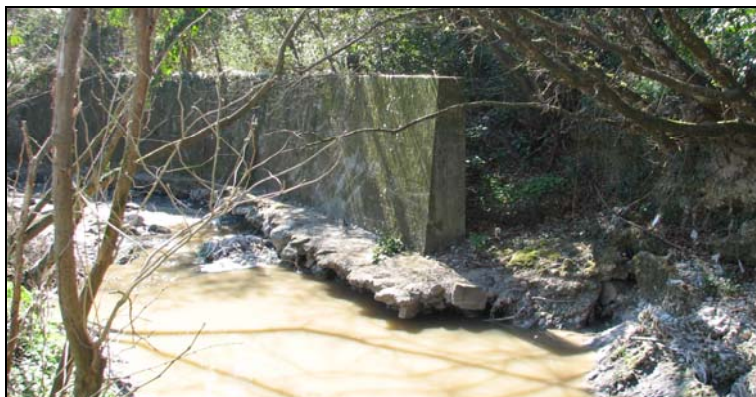
FOTO 23 - muro di sostegno per il terrapieno del Viale Cristoforo Colombo
