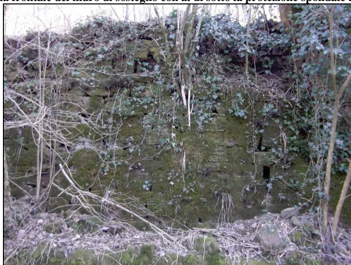
FOTO 7 - particolare del muro di sostegno in pietra locale.
