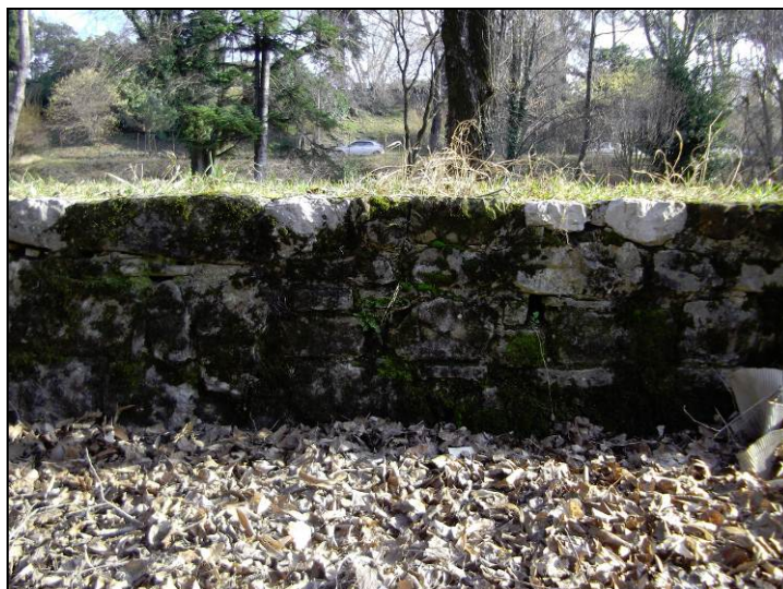
FOTO 2 - particolare del muretto che delimita il torrente Corno coperto. La pietra è locale, tipo carsica o arenacea marnosa. Il progetto non prevede alcun cambiamento dello stato attuale.
