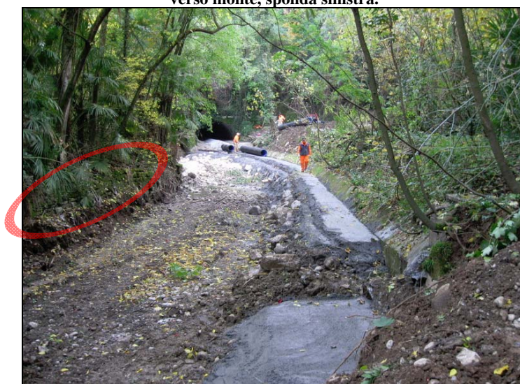
FOTO 19 - muretto di protezione spondale a valle del terrapieno di Viale Oriani. Lunghezza della protezione circa 10 metri. Particolare vedi vista frontale sotto.
