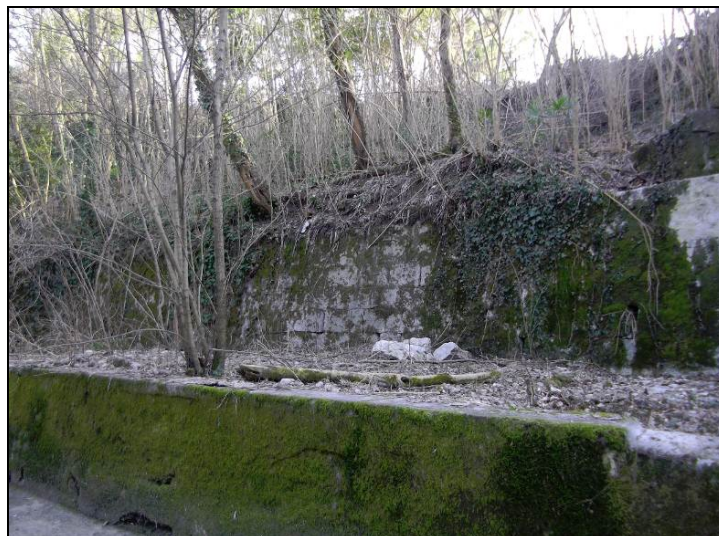
FOTO 11 - muro di contenimento della scarpata di via Italcico Brass in pietra, a monte del vecchio ponte di via del Boschetto.
