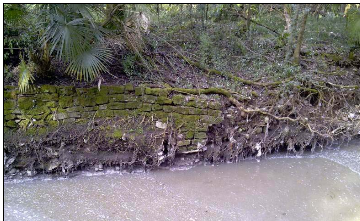
FOTO 20 - particolare (vista frontale) del muretto in pietra di protezione spondale di cui sopra. L'intervento ne prevede il mantenimento e la sua sistemazione.
