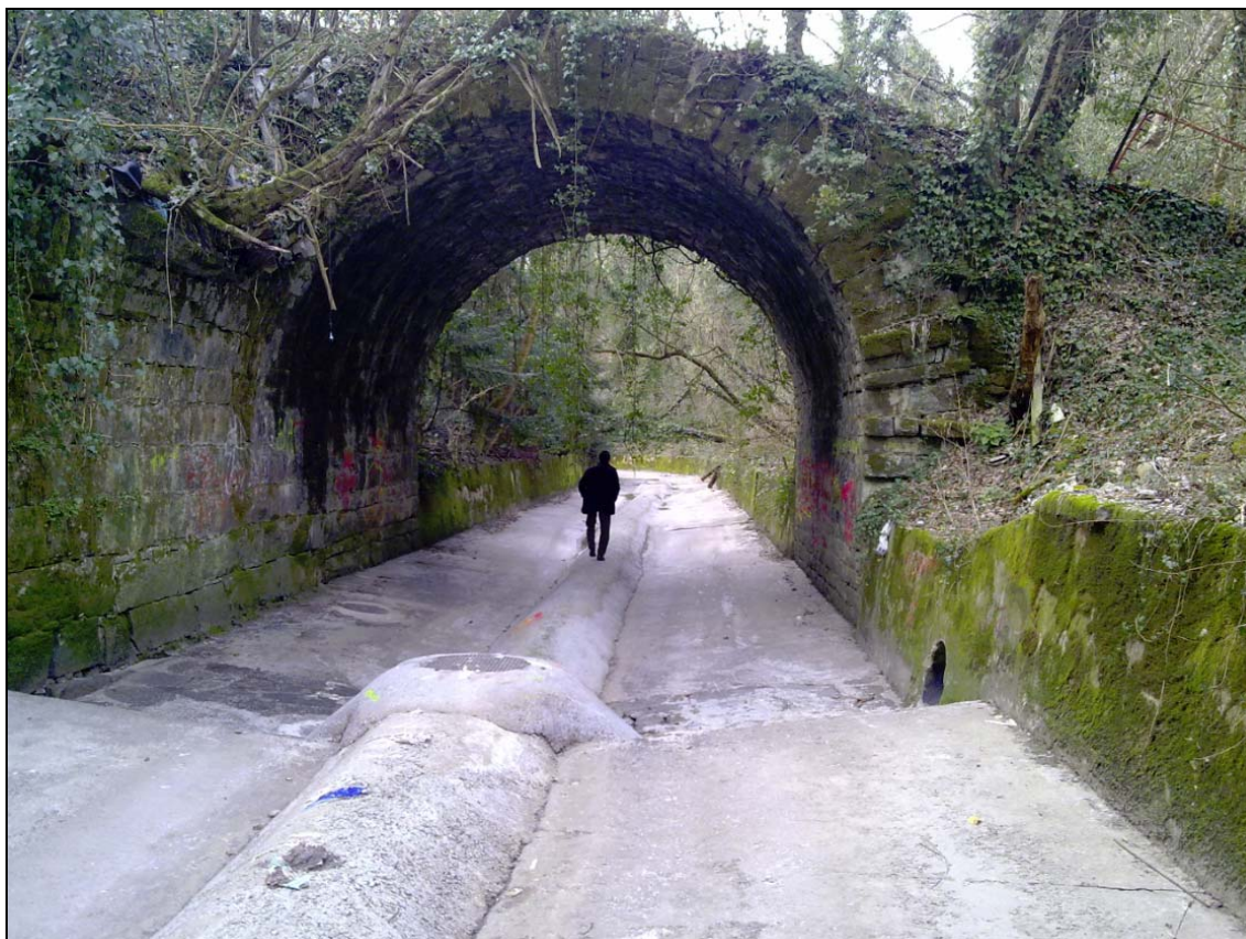
Figura 59: STATO DI FATTO del vecchio ponte in pietra di via del Boschetto all'interno della Valletta.
