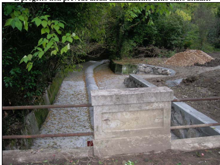
FOTO 3 - Inizio del tratto scoperto del torrente Corno: particolare dello sbocco. Si nota in primo piano la vecchia protezione in calcestruzzo e tubolari in acciaio che delimita il tratto tombato.
