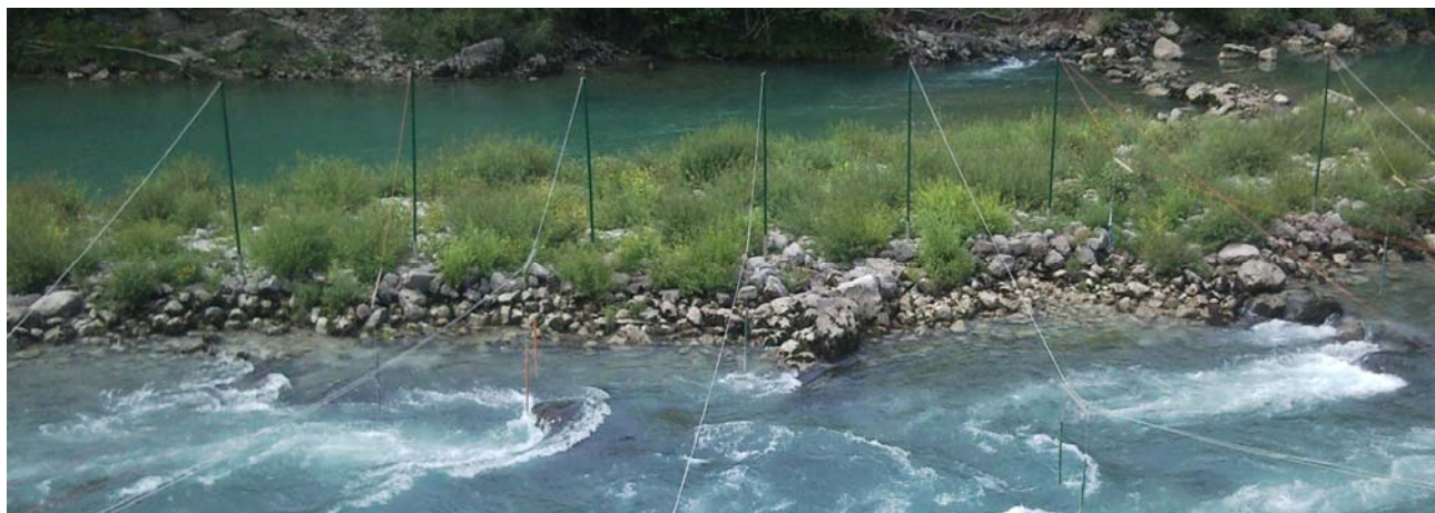
Figura 67: sistemazione spondale in sassi e pietre lungo il fiume Isonzo a Salcano.
