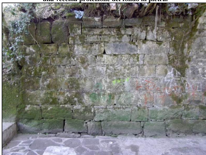
FOTO 10 - muro di protezione spondale in prossimità del vecchio ponte in pietra di via del Boschetto. Il progetto prevede la manutenzione di queste emergenze architettoniche e la realizzazione di tutti i manufatti in progetto con la stessa tipologia di pietra e la medesima "texture", al fine dell'ottimale inserimento paesaggistico.
