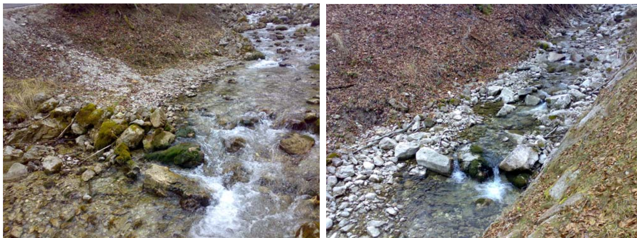
Figura 64: sistemazione spondale e step-pool in lungo il Rio del Lago a Fusine – intervento realizzato dalla Studio Causero nell’anno 2007.
