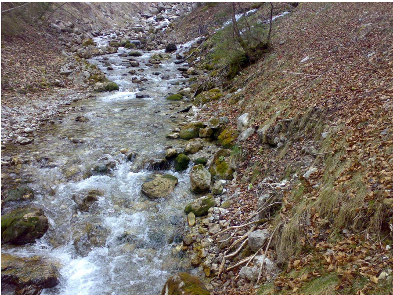
Figura 65: sistemazione spondale e step-pool in lungo il Rio del Lago a Fusine – intervento realizzato dalla Studio Causero nell’anno 2007.
