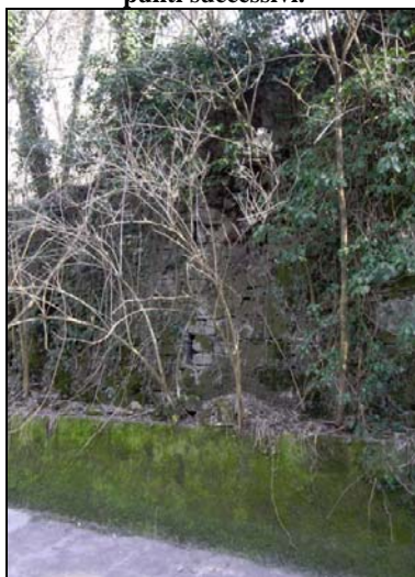
FOTO 5 - particolare del muro di sostegno di cui sopra addossato alla protezione spondale in calcestruzzo esistente.
