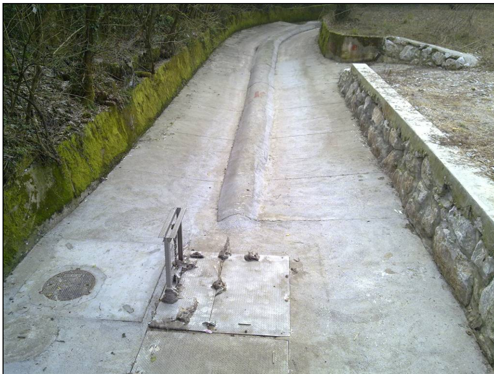
Figura 39: il torrente Corno canalizzato all'inizio del tratto a cielo aperto nel parco della Valletta.
